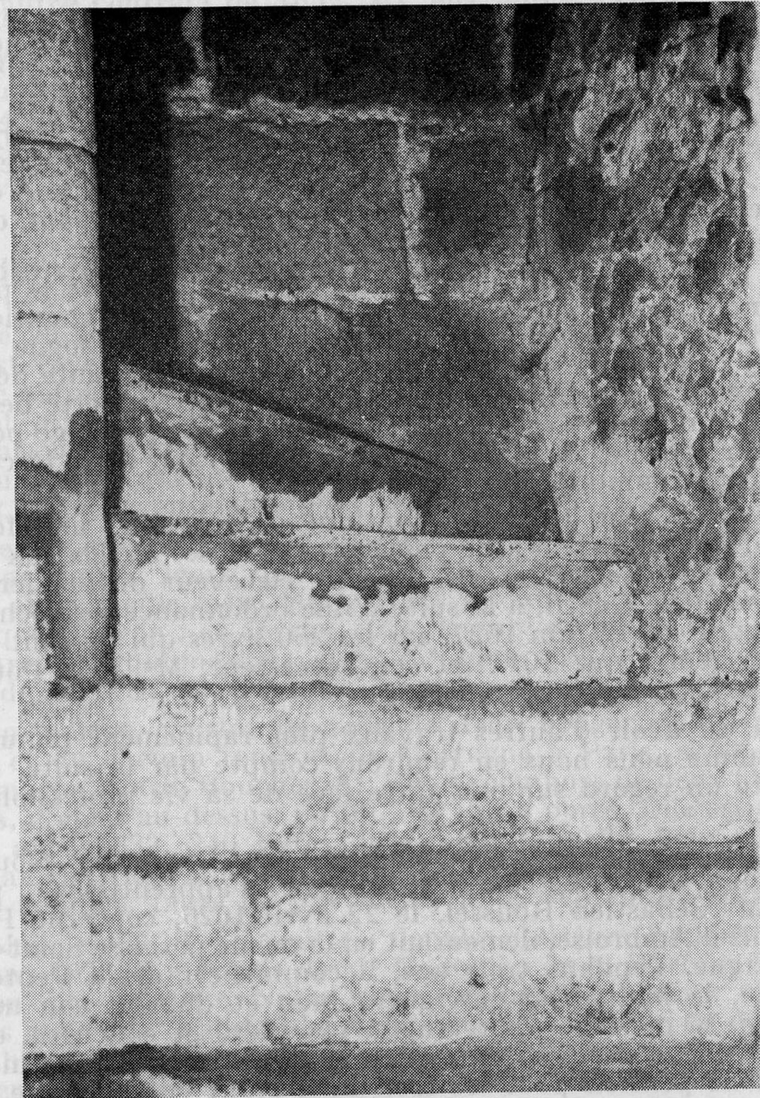
La « montée d'escalier » de pierre blanche construite par Jean Guyon à l'église Saint-Aubin de Tourouvre, humble témoignage du travail d'un ancêtre de milliers de Canadiens-Français.
